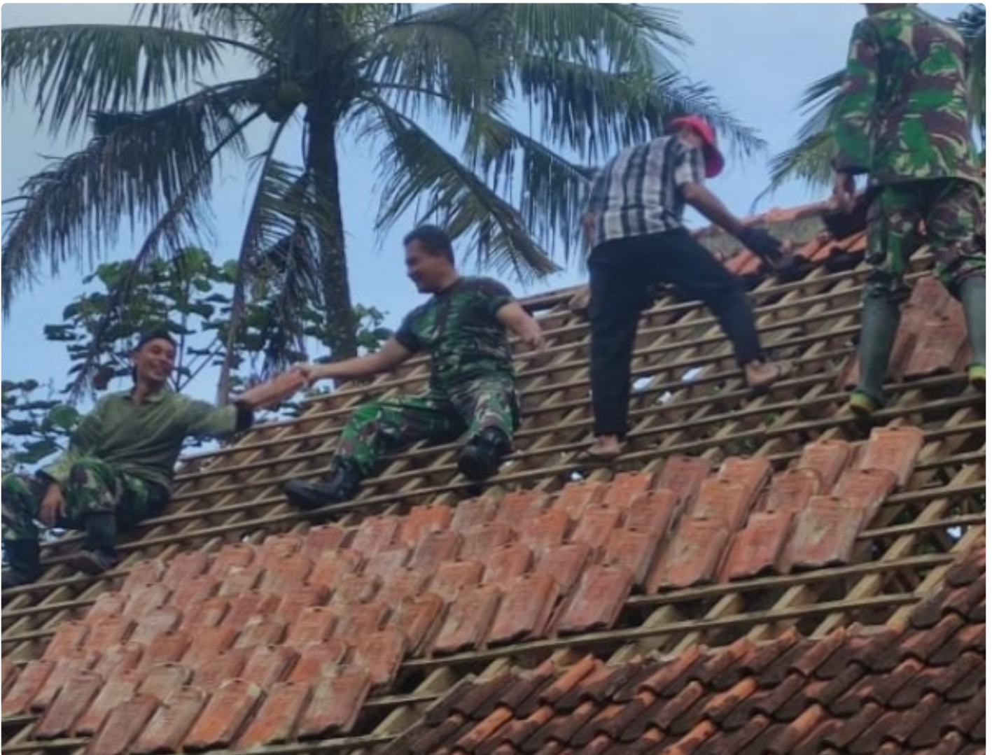
Dampak Retakan Tanah, Koramil 10/Gandrungmangu Bersama Warga Perbaiki Rumah Kastaja
